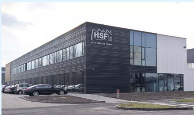
Sídlo firmy HSF – Ostrava Business, Ostrava
