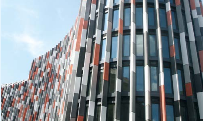
Administrativní komplex Main Point Karlín, Praha
